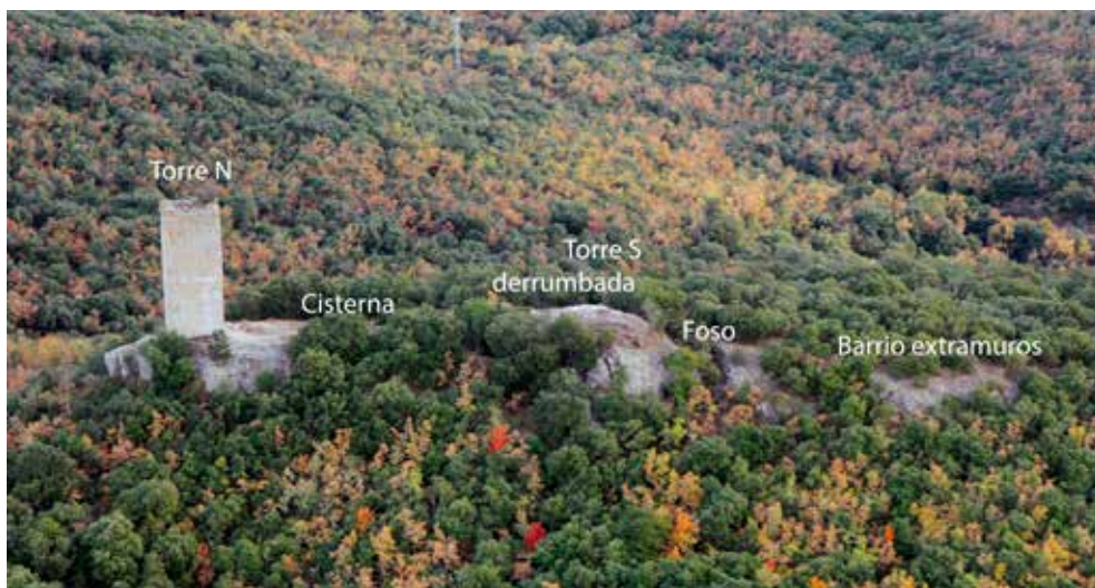
Principales estructuras identificadas en la excavación.
