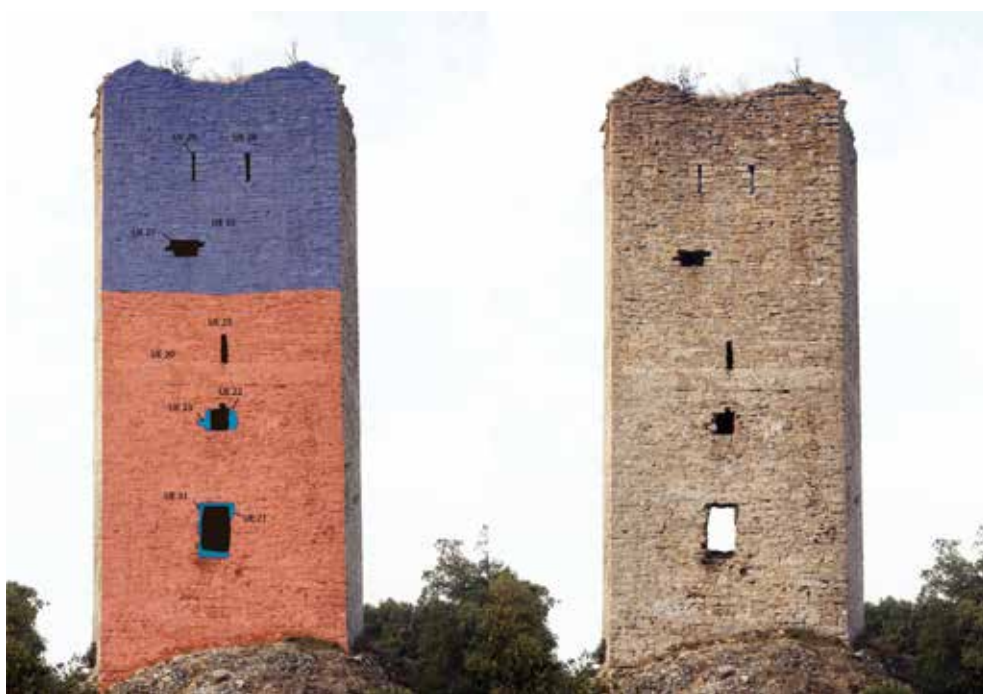
Fases constructivas de la torre medieval.
